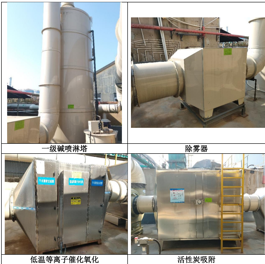
图4.1-4 车间废气和罐区废气治理设施图片
