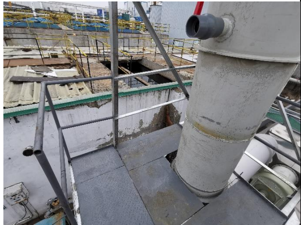
1#排气筒采样平台
